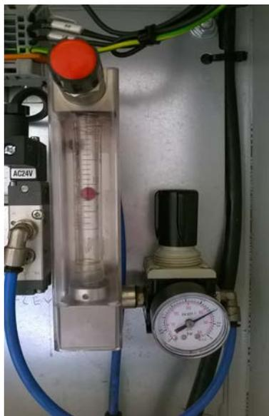
Imagen 6.4. Válvulas para regular caudal y presión del aire de entrada en el DAF
