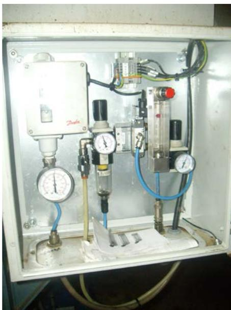
Imagen 4.10. Equipo regulador de caudal de entrada de aire al DAF
