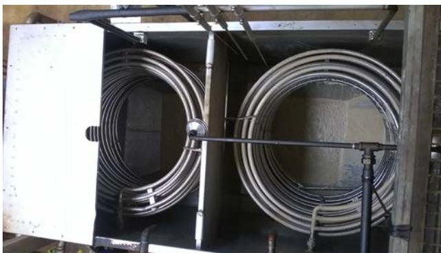
Imagen 4.6. Vista superior de los dos compartimentos del tanque con sendos serpentines por los que circula el vapor
