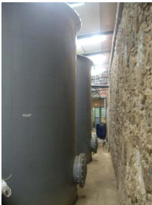
Imagen 4.1. Tanques de homogeneización en el interior de la nave
