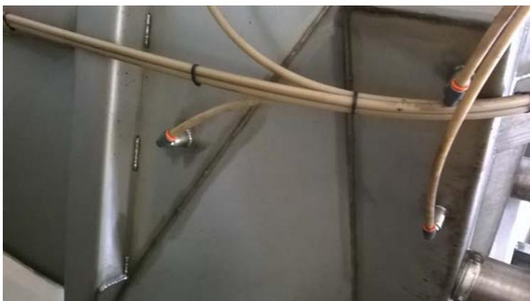
Imagen 4.4. Inyectores del caudal de recirculación al interior del tanque
