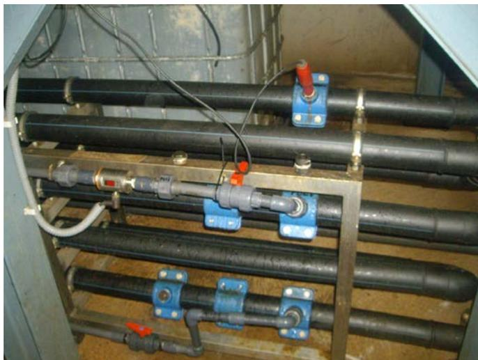
Imagen 4.5. Floculador perteneciente al equipo de flotación DAF
