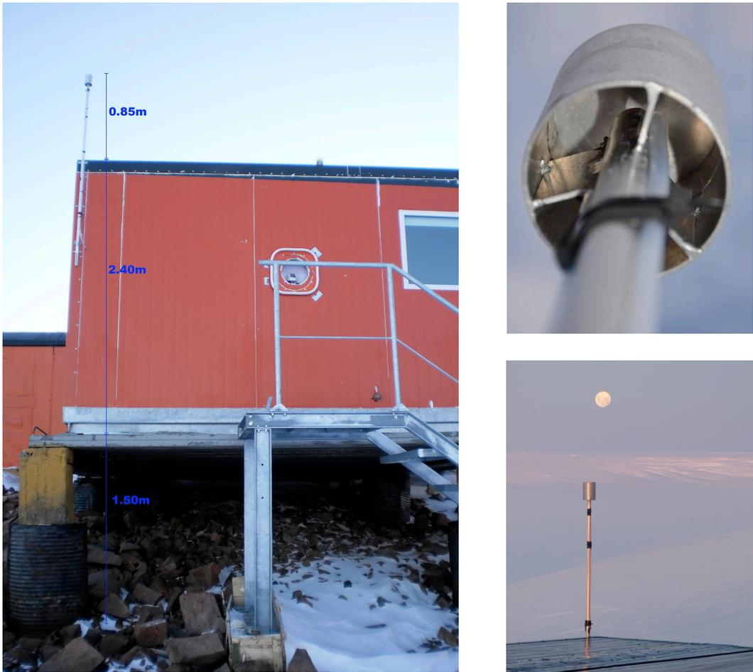
Figura 3.3. Izquierda: toma de aire exterior sobre el techo del edificio. Derecha: detalle de la entrada de aire.
