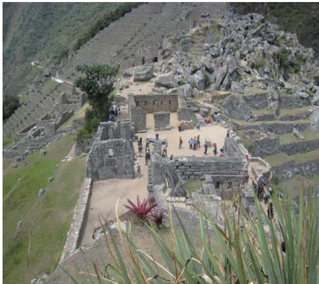
Figura 19. Un sector de Machu Picchu. Al fondo, a la izquierda, un conjunto de terrazas agrícolas. Al fondo, a la derecha, "caos granítico". Nótese el apilamiento de los bloques graníticos que los incas utilizaron como cantera. De los bloques extraídos se confeccionaban paralelepípedos de todo tamaño. Este lugar es conocido actualmente como "La Cantera".
