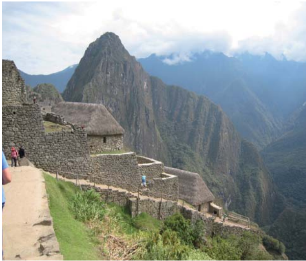
Figura 18. Un pequeño sector de la parte urbana de Machu Picchu. Las casas han sido techadas en los últimos años tratando de reproducir técnicas antiguas.
