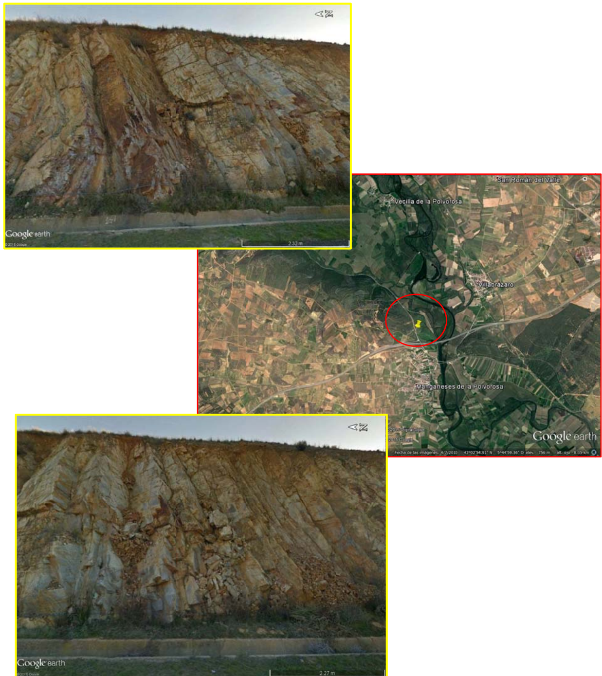
Figura 3. Taludes de la carretera ZA-P-1511, entre Manganeses de la Polvorosa y Morales del Rey (Zamora). Imágenes de Google Earth y de Street View.
