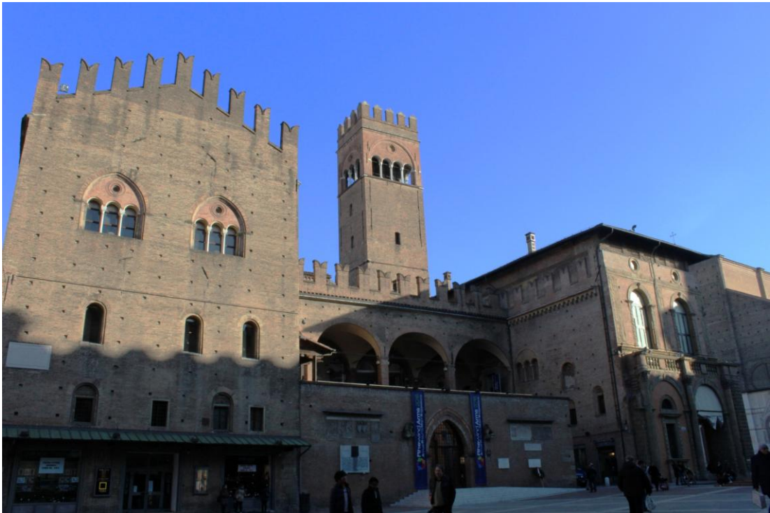
18. Fachada que une el palazzo Re Enzo con el del Podestà*.
