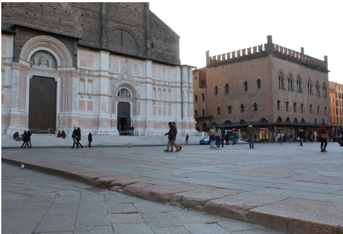
86. Crescentone dañado por un tanque estadounidense en 1945*
