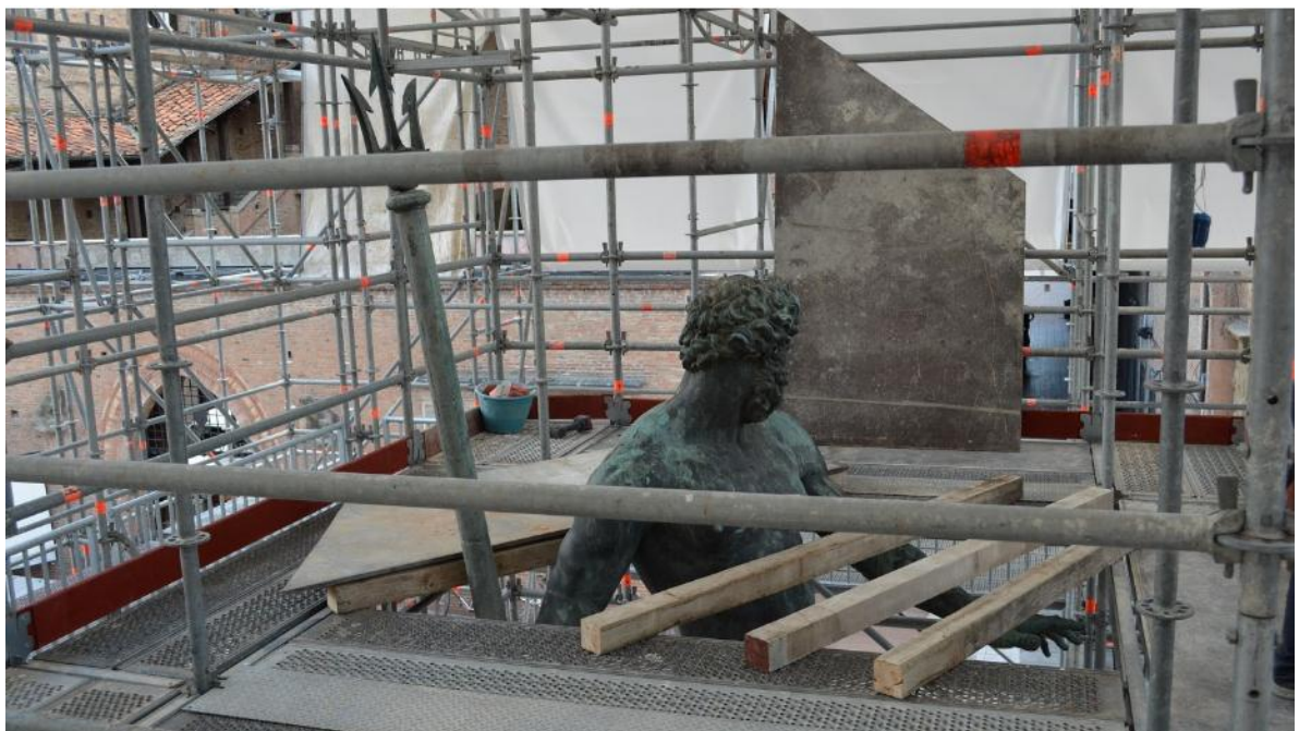
88. Labores de conservación en la fontana del Nettuno .
