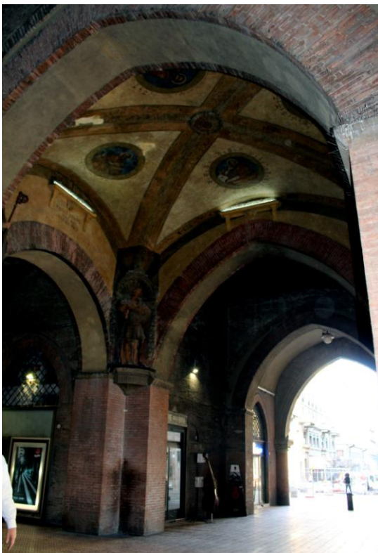
12. Voltone del Podestà* . La planta baja del palazzo Comunale contaba en su origen con una vía abovedada con arcos apuntados, formando el primer brazo del cruce de vías que se da posteriormente y que recibirá el nombre de Voltone del Podestà .
