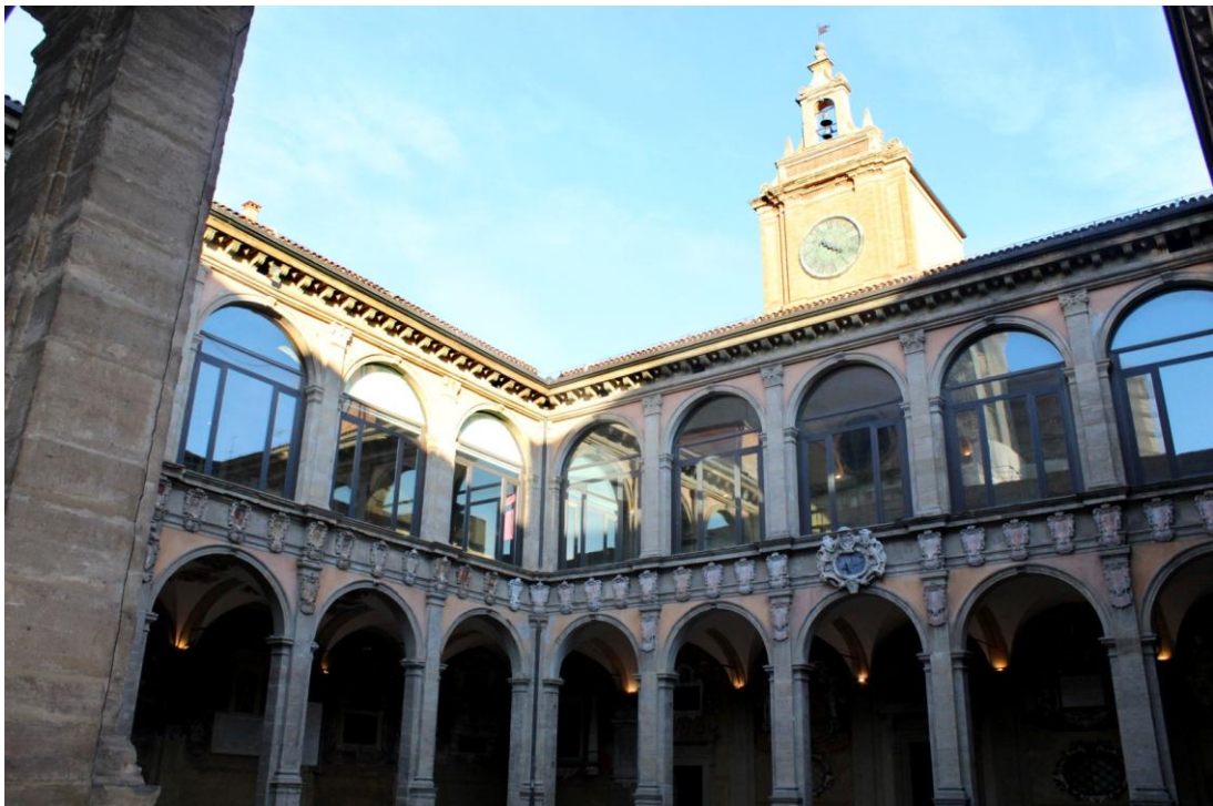
43. Patio interior del palazzo dell'Archiginnasio * El edificio se articula en dos pisos en torno a un patio central con dos órdenes diferentes en las logias.
