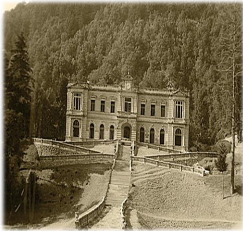
ILUSTRACIÓN 26. Fachada de La Castañeda.
