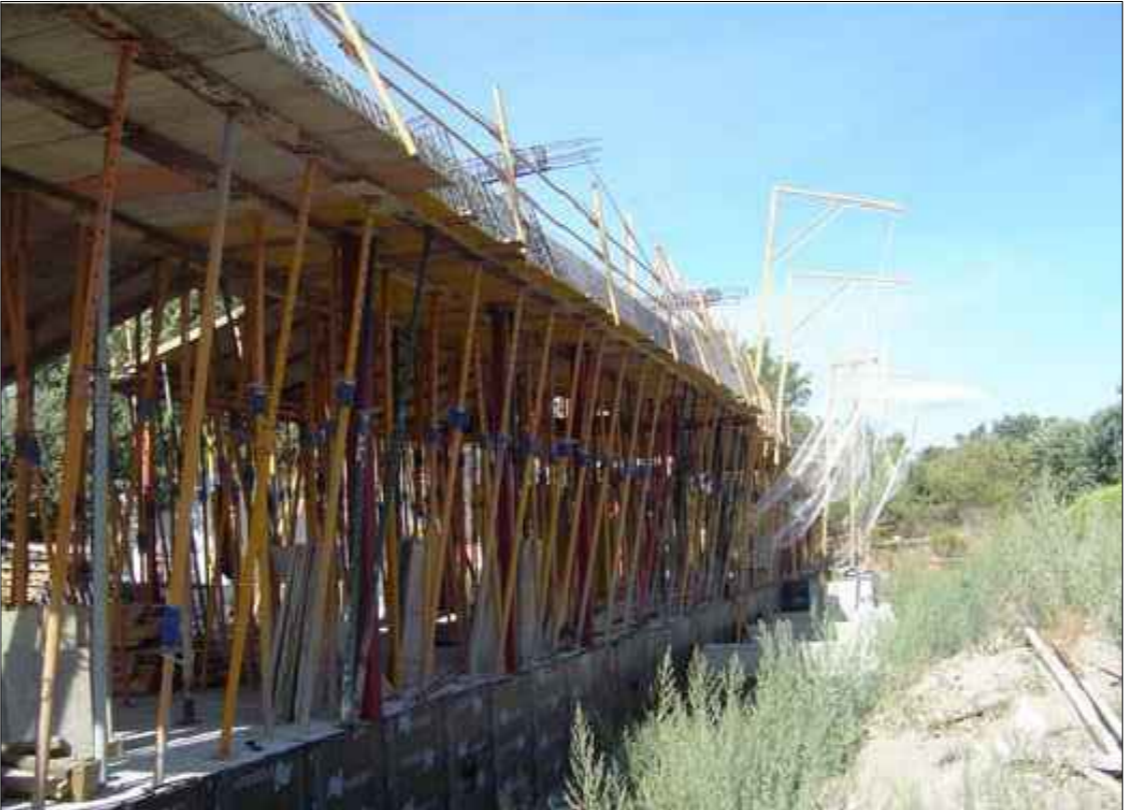
Pilares ejecutados, colocación del encofrado del forjado de planta primera
