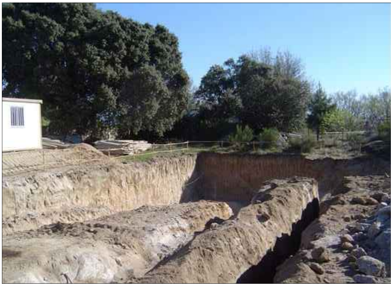
Vaciado de la cimentación
