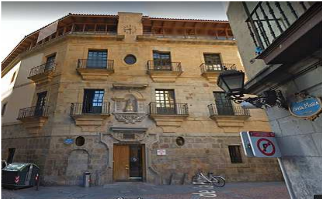
Fig. 4.4. Delegación en Bilbao. Edificio de la Bolsa. Calle Pelota, núm. 10
