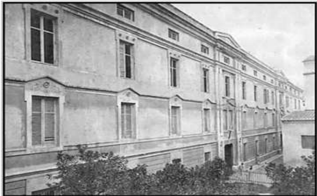
Fig. 4.12. Valencia. Depósito documental. Casa de la Misericordia (edificio derribado en 1949). Antigua plaza de San Miguel, núm. 4
