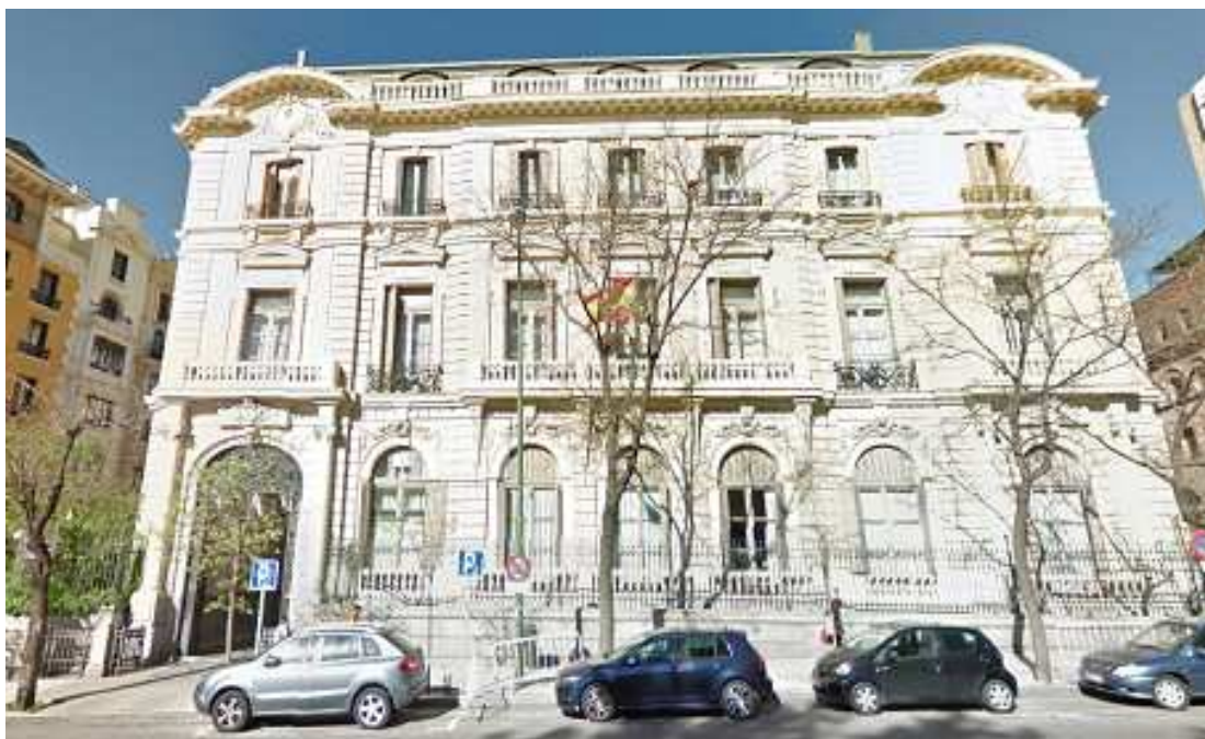
Fig. 4.9. Madrid. Depósito documental. Calle Santa Engracia, núm. 7
