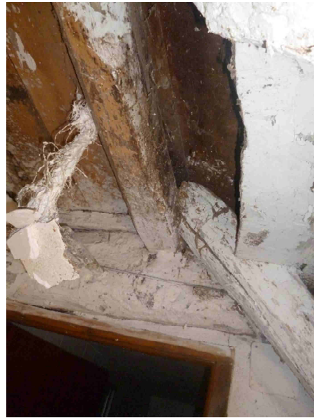
Encuentro de zanca con viga descansillo
