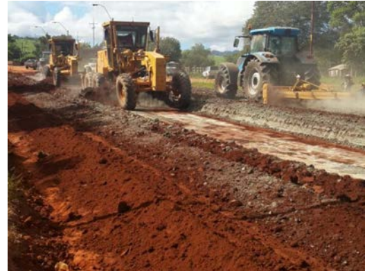
Figura 11. Rotovator agrícola en tareas de mezcla, apoyado por motoniveladoras. Fuente: COMYCSA
