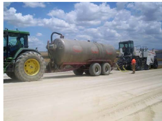
Figura 11. Acople de máquina estabilizadora y cuba de riego. Fuente: Agencia de Obra Pública de la Junta de Andalucía
