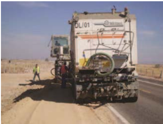
Figura 2. Obra de ensanche ejecutada con suelocemento in situ. Fuente: IECA
