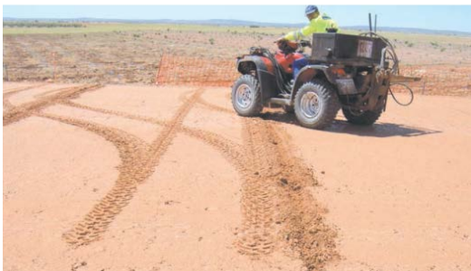
Figura 24. Quad adaptado para ejecutar prefisuraciones. Fuente: ATC-PIARC
