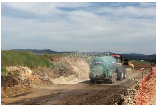
Figura 26. Cuba de agua remolcada por tractor. Fuente: COPUGASA
