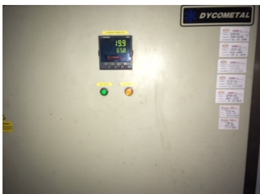
Figura 20. Condiciones de curado en cámara húmeda. 20°C y 65% humedad. Fuente: propia
