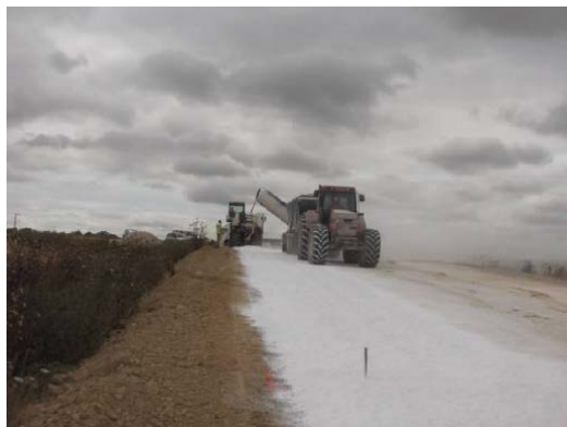
Figura 12. Dosificación de cal por vía húmeda en el tramo de prueba. Fuente: Agencia de Obra Pública de la Junta de Andalucía
