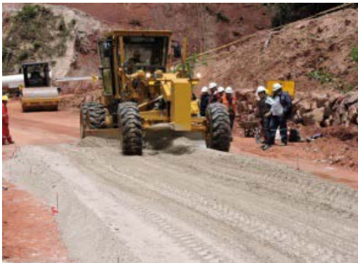
Figura 13. Motoniveladora mezclando suelocemento in situ. Fuente: Administración Boliviana de Carreteras
