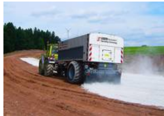
Figura 8. Dosificador de conglomerantes remolcado. Fuente: Streumaster
