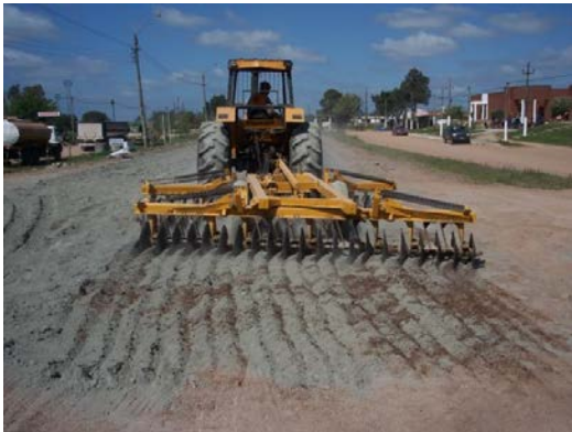
Figura 12. Grada de discos mezclando suelocemento. Fuente: Desconocida
