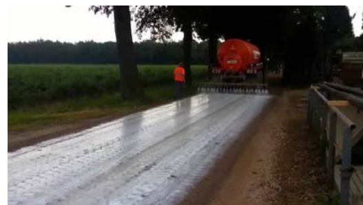
Figura 25. Cuba sobre camión aplicando riego de polímeros. Fuente: SOLID I+C
