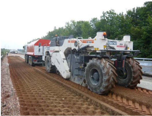
Figura 3. Vista del suelo tras la compactación con rodillo pata de cabra
