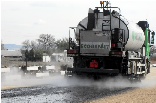
Figura 28. Cuba de riego de emulsión asfáltica. Fuente: ECOASFALT
