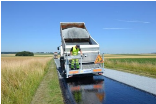
Figura 27. Gravilladora sobre camión. Fuente: SECMAIR
