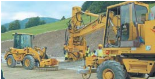
Figura 23. Sistema JOINT-ACTIF. Pala cargadora para ejecutar surco y excavadora de neumáticos para disponer el perfil plástico. Fuente: ATC-PIARC
