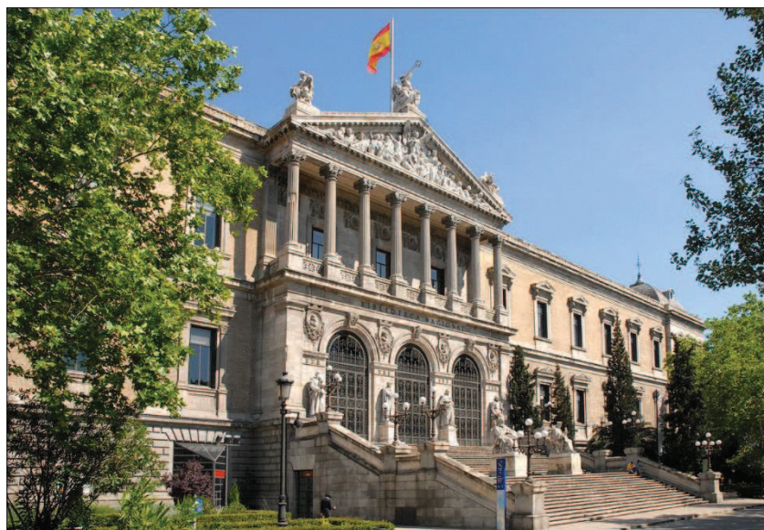
Figura 5. Fachada de la Biblioteca Nacional de España.
