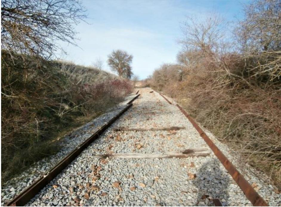
*Fig. 3 Rieles desmantelados y traviesas retiradas a la altura de la A-11. Foto de autor.*
