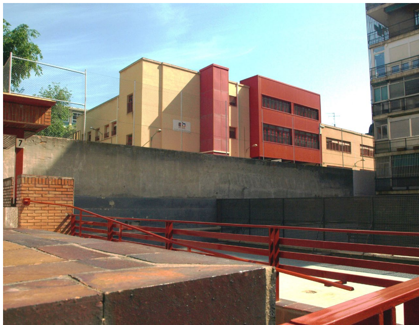
Fig. 6: CEIP «San Juan de la Cruz». Estado actual. Vista posterior, desde la calle Nuestra S a de Luján.
