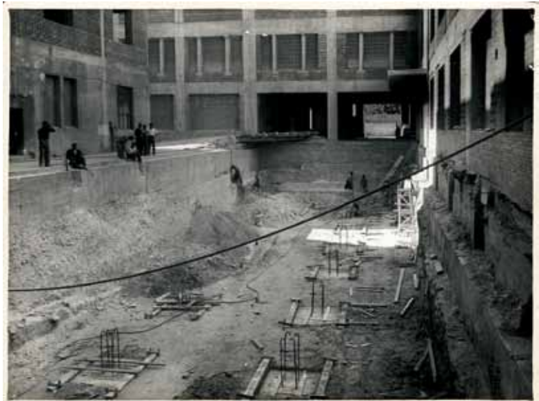
FNMT Jorge Juan en construcción, 1956.
