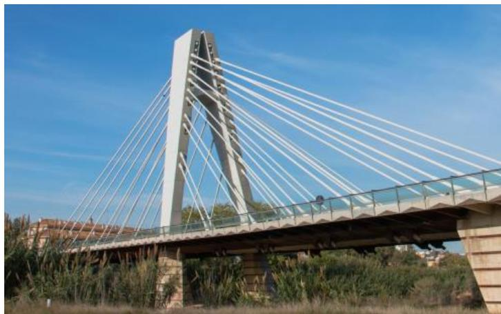
*Figura 5: Puente atirantado sobre el río Turia de hormigón fabricado con un 20% de áridos reciclados. Fuente: (P. Alaejos et al., 2005).*
