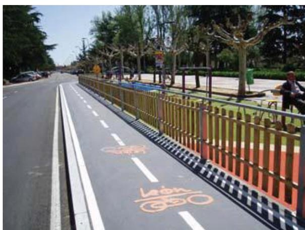
*Figura 6: Carril bici con pavimento de hormigón reciclado. Fuente: (Ieca, 2013).*
