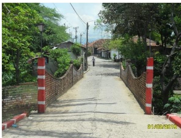
Figura 81. Puente de Calicanto
