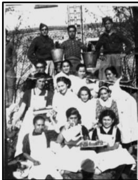
Figura 24. Grupo de sanitarias del Hospital Militar. (305).
