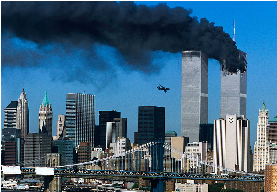
Imagen del 9/11 con el segundo avión a punto de impactar en la torre
