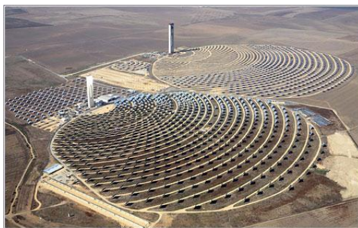
Figura 1. Ejemplo de planta termosolar de torre de concentración central (plantas PS10 y PS20, Sanlúcar la Mayor, Sevilla). Foto de Abengoa Solar [ http://www.abengoasolar.com ].
