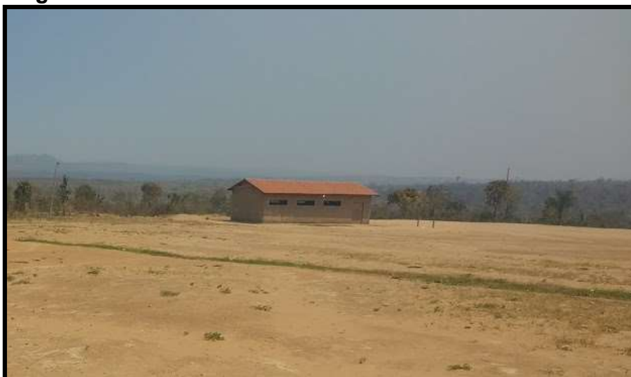
Figura 16: Prédio da biblioteca.
