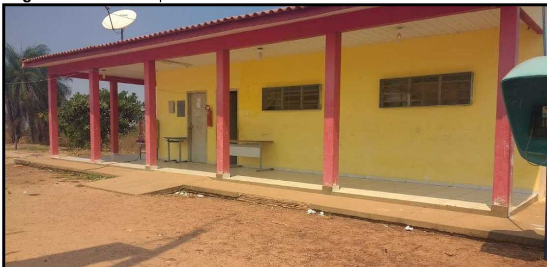
Figura 12: Frente de prédio da escola da aldeia.
