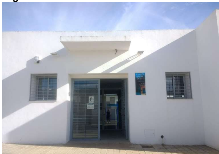
Figura 36: Entrada da biblioteca de San Isidro.
