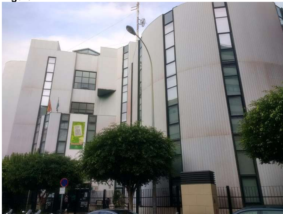
Figura 27: Fachada da biblioteca de Almería.
