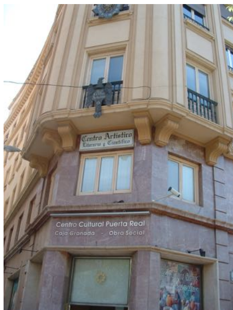
1. OLMEDO COLLANTES, Miguel: Edificio Isabel la Católica. Granada.
