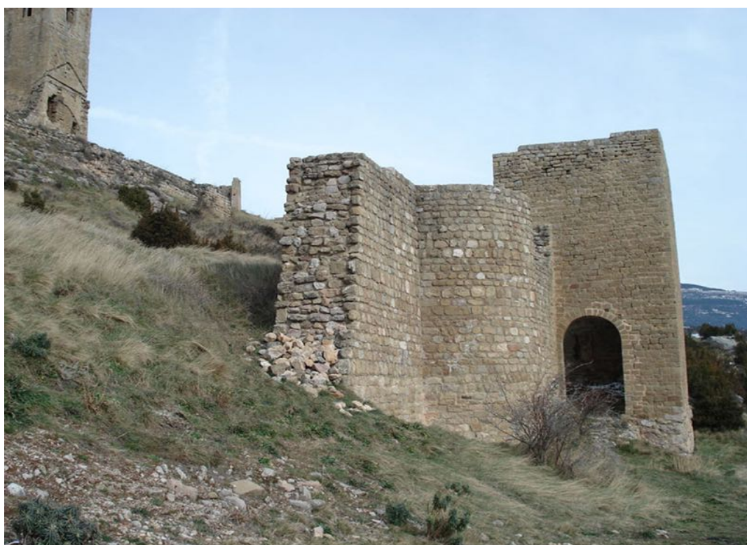
4. Fotografía del autor: Reconstrucción del tramo de muralla con su torre en la actualidad , 2008.
