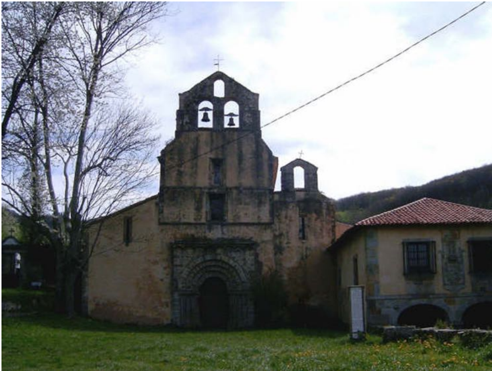
3. Fachada occidental de la iglesia y entrada al monasterio de Santa María la Real de Obona (Arzobispado de Oviedo), Tineo, (Asturias, España)
