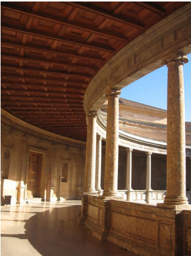
6. Imagen de autor: Galería del piso superior, con cubrición. Palacio de Carlos V, 2008, Granada (España).
