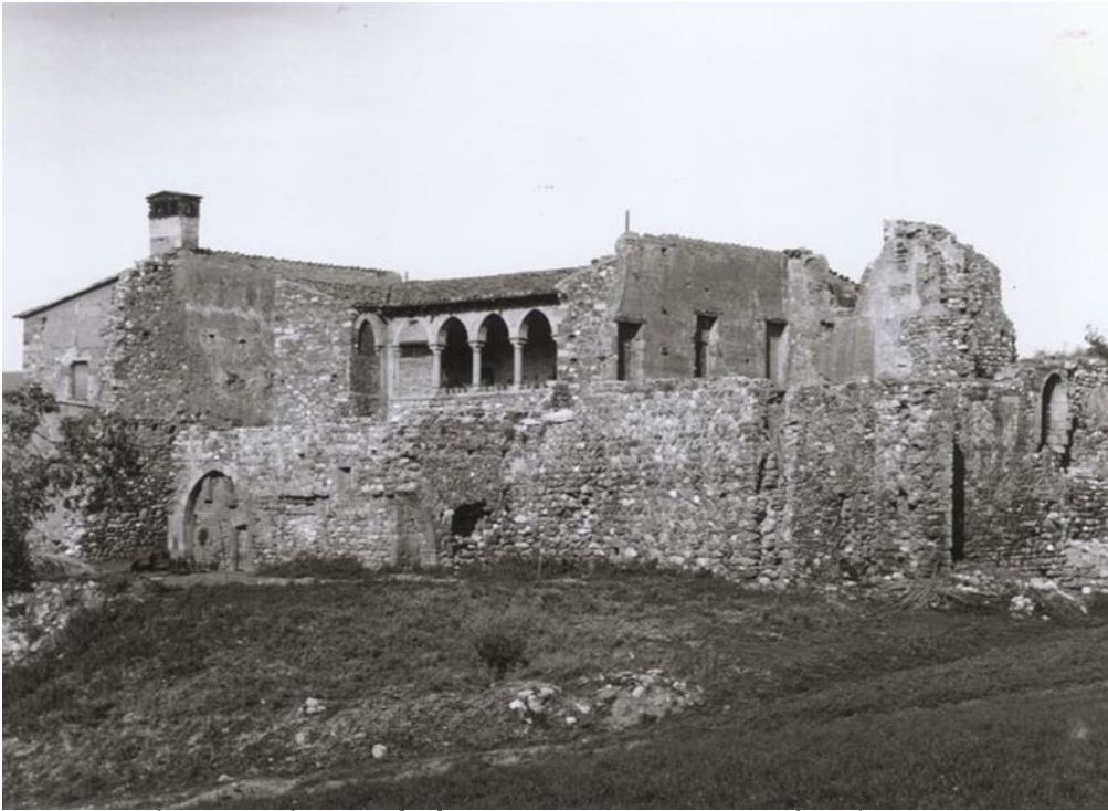
5. Autor desconocido: Estado de conservación. Vista general , 1943, SCCM-SPAL.
