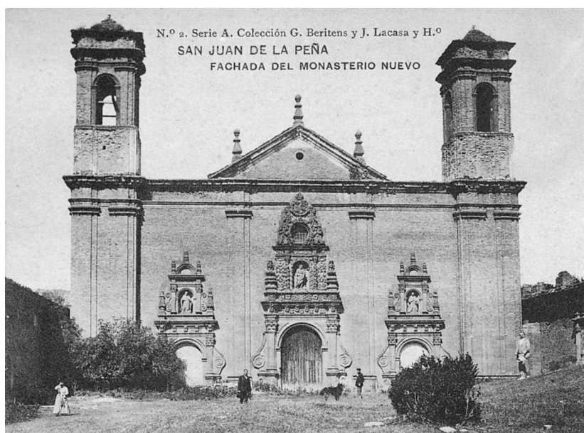
5. BERITENS Y LACASA: Fachada de la iglesia del monasterio nuevo de San Juan de la Peña, fotografía, Archivo de Fotografía e Imagen del Altoaragón de la Diputación Provincial de Huesca, Colección Beritens, Lacasa y Hermano 02.
