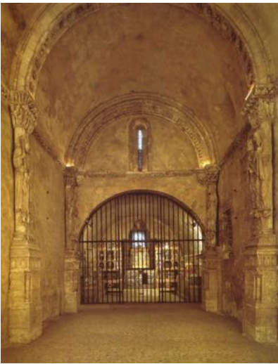
2. La Cámara Santa hoy. La reconstrucción de posguerra cobra valor de original.
