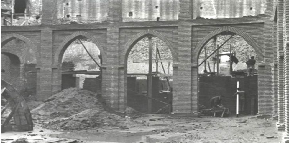
1. Autor desconocido: Trabajos de reconstrucción de una de las alas del patio , 1939-1942, Archivo General de la Administración, 037 F/04384.
