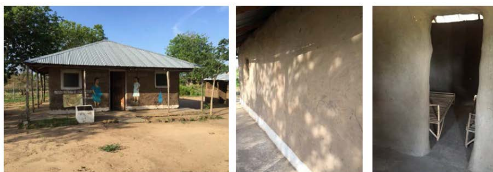
Figura 1 – Construcciones de paredes de tierra en el PNG.
