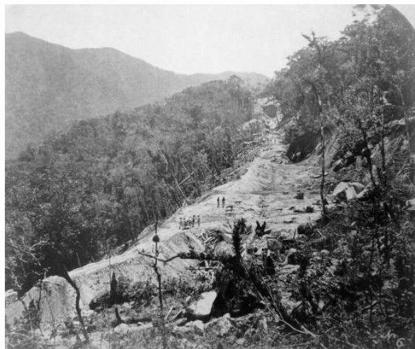
Fig. 32: Imagem da construção de trecho na Serra do Mar
