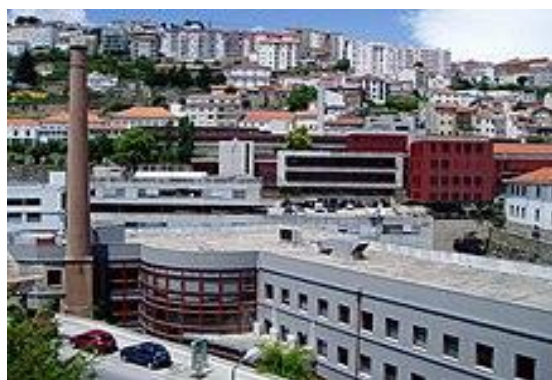
Fig. 38: Instalações da UBI em antigas Indústrias.
