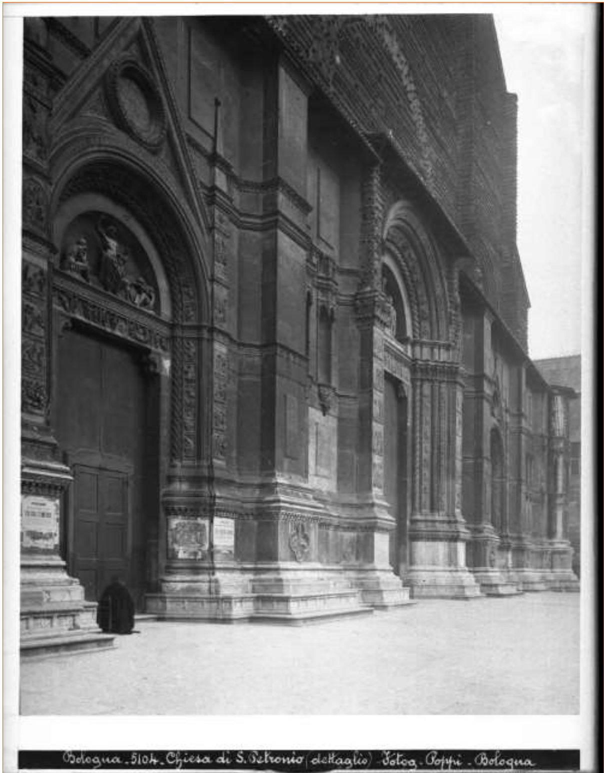
Figura 84. Aspecto anterior a la primera limpieza.
