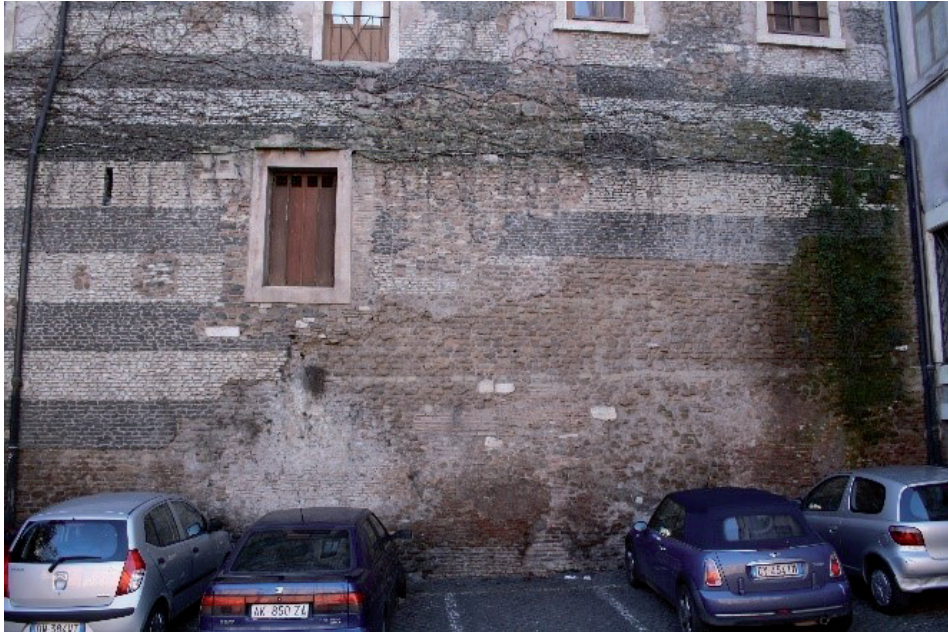
FIG. 11 Particolare del paramento vergato nell'edificio presso la Salita dei Borgia.
