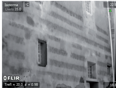
FIG. 13 Termografia del prospetto in opera vergata, all'interno del complesso dei SS. Quattro Coronati (per gentile concessione di L. Barelli).
