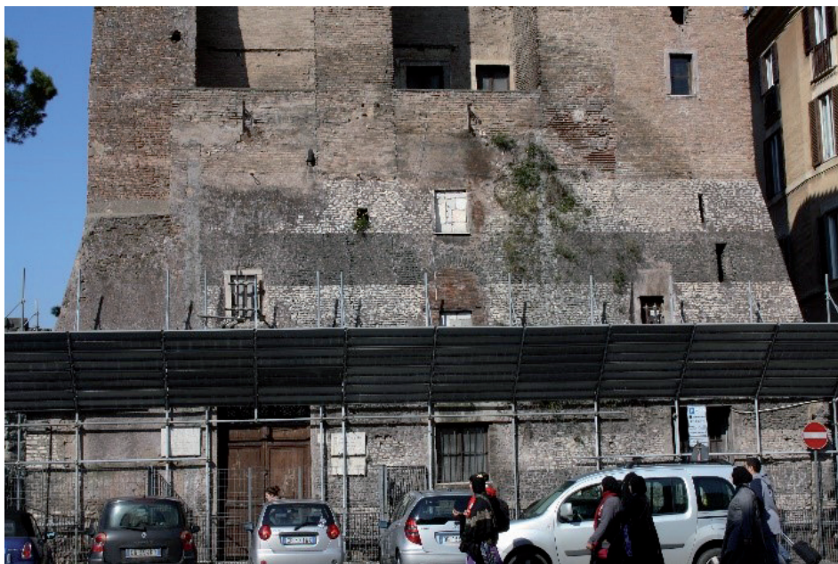
FIG. 12 Particolare del paramento vergato della Torre dei Conti.
