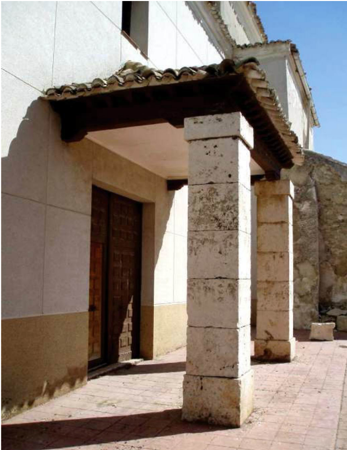
Pórtico lateral, sustentado por sendos soportes de «piedra almendrilla» procedente de las canteras locales y empleada en diversas obras del Real Sitio.
