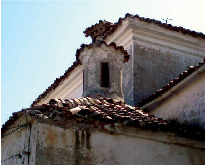
Estado de la cubierta de la capilla barroca de la zona del Evangelio, rematada por un pequeño linternín.
