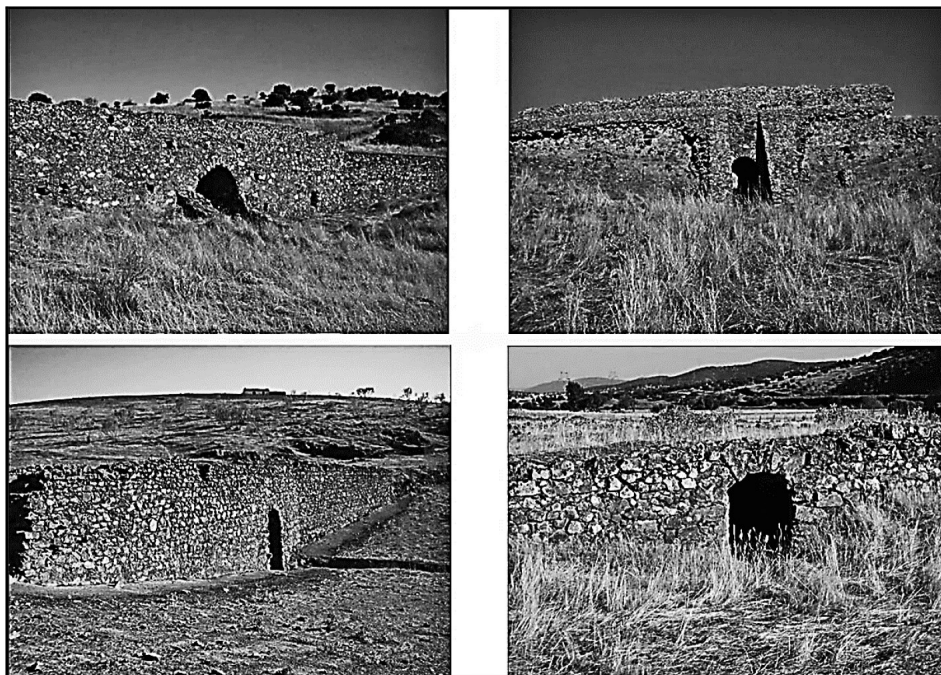
FIGURA 4: Cuatro puentes 72 del camino de Sevilla en las afueras de Almadén.
