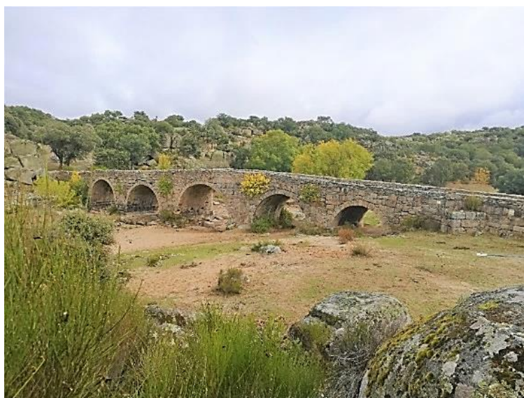
Ilustración 14. Puente mocho de Ledesma (Fuente: elaboración propia)
