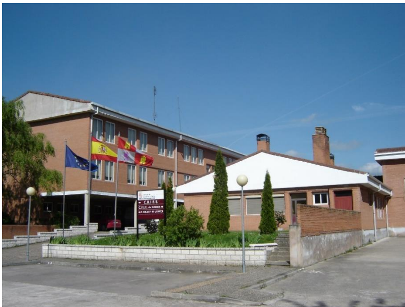
Figura 4.20. Instalaciones del CRIEB de Burgos
