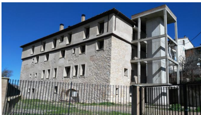
Figura 2.9. Edificio del CRIE de Benabarre (Huesca) en el Albergue de Benabarre. Antiguo Hospital de Santa Elena
