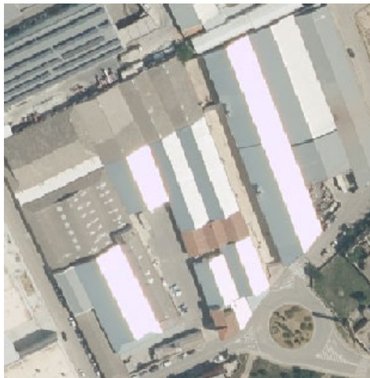
Imagen 6. Ejemplo de reflejo producido por la incidencia de los rayos del sol sobre una superficie metálica.
