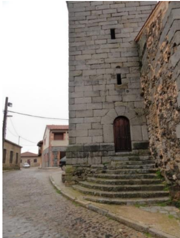
Imagen 23. Acceso a la torre. Fuente: Elaboración propia
