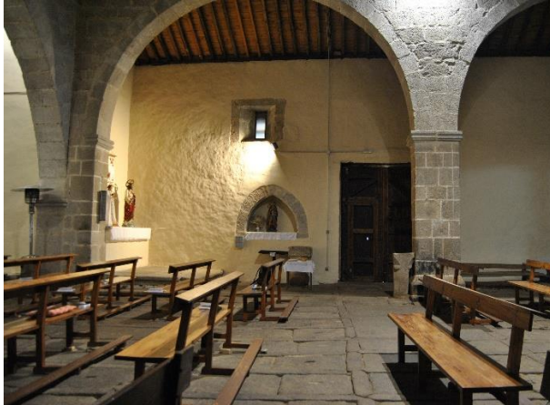
Imagen 26. Pilares de piedra. Fuente: Elaboración propia
