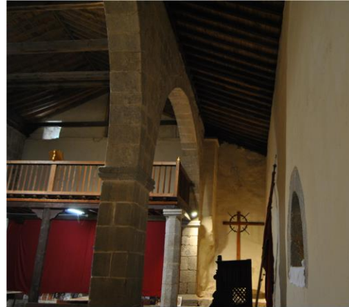
Imagen 27. Pilares de piedra. Fuente: Elaboración propia
