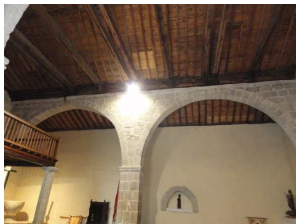
Imagen 8. Arcos de medio punto que separan la nave central de las laterales. Fuente: Elaboración propia
