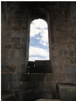
Imagen 11. Vista interior de un ventanal del campanario. Fuente: Elaboración propia
