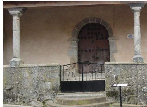
Imagen 17. Columnas del pórtico y puerta de acceso frontal. Fuente: Elaboración propia
