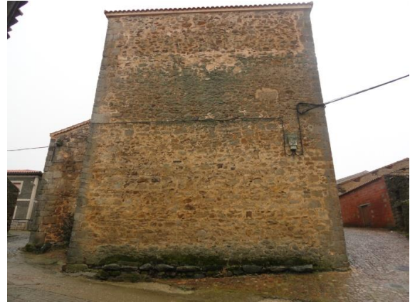
Imagen 10. Fachada Este del ábside. Fuente: Elaboración propia
