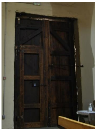
Imagen 37. Puerta principal, vista interior. Rehabilitada. Fuente: Elaboración propia
