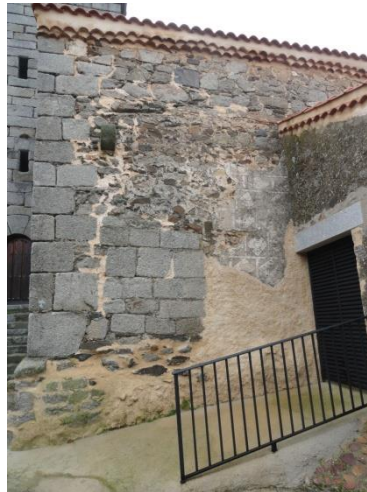
Imagen 18. Acceso lateral a pórtico. Fuente: Elaboración propia
