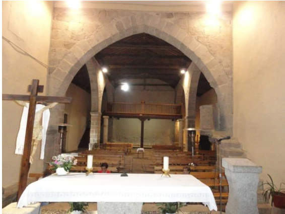
Imagen 9. Arco ojival, que separa la nave del ábside. Fuente: Elaboración propia
