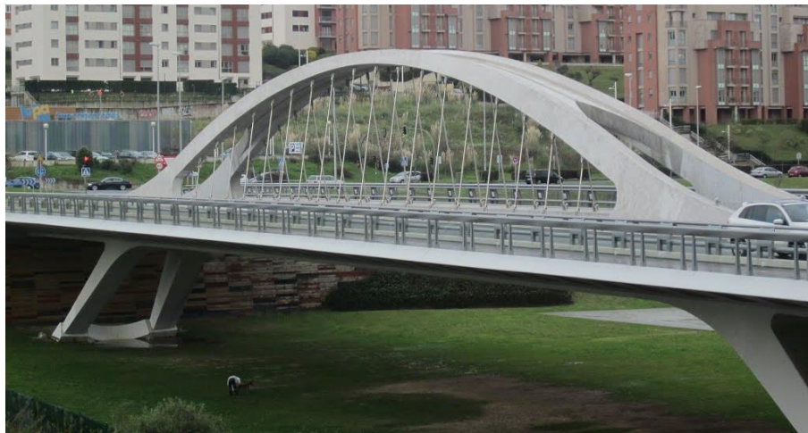
Figura 1.1. Puente arco con tablero intermedio de las Llamas en Santander (Mapio.net).
