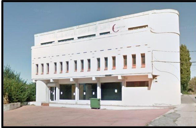
Figura 6.1: Fachada de la nave
