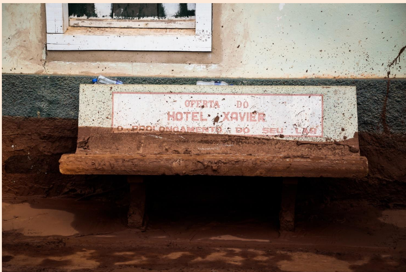
Banco en frente del Hotel Xavier, marcado por el barro que invadió la ciudad/Banco em frente ao Hotel Xavier marcado pela lama que invadiu a cidade (Barra Longa, Minas Gerais).
