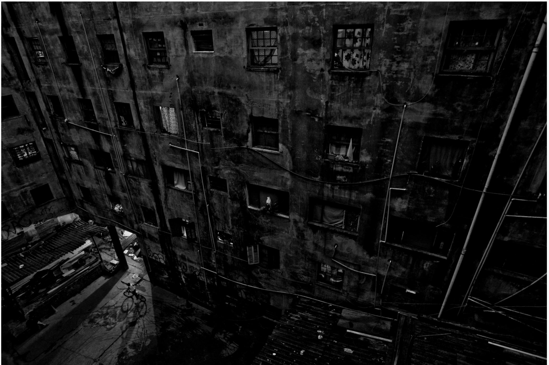
Vista del patio interior de la ocupación Mauá, donde viven aproximadamente 200 familias/Vista do pátio interno da ocupação Mauá, onde aproximadamente 200 famílias vivem.
