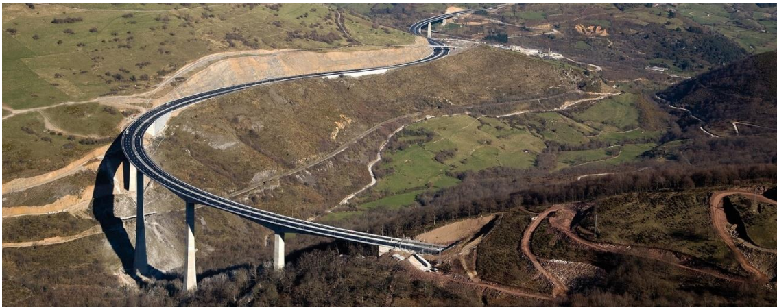
Fig. 26 WSP. Vista aérea de caminos acondicionados. Viaducto de Montabliz
