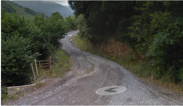
Fig. 24 Captura Google maps. Camino para rehabilitar
