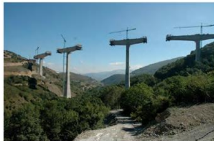
Fig. 23Revilla Angulo R. Imagen de construcción por sistema autoportante
