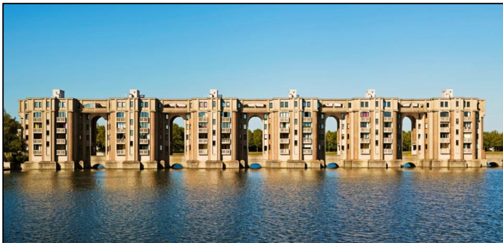
Figura XXI. Edificio Le Viaduc en Les Arcades et les Temples du Lac (1986). Saint-Quentin-en-Yvelines, Île-de-France (Francia). Fuente: RBTA
