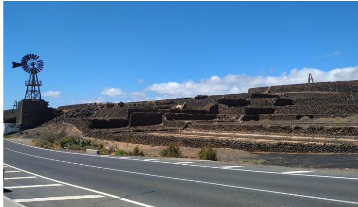
Fig. 7. Las salinas del puerto de Naos. Foto del autor.
