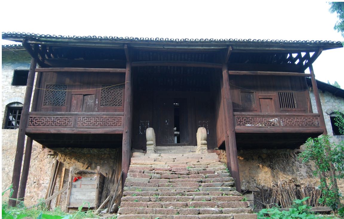
Foto 4.11. Sala Ancestral de Tusi, (El edificio en zancos con estructura Chuandou)
