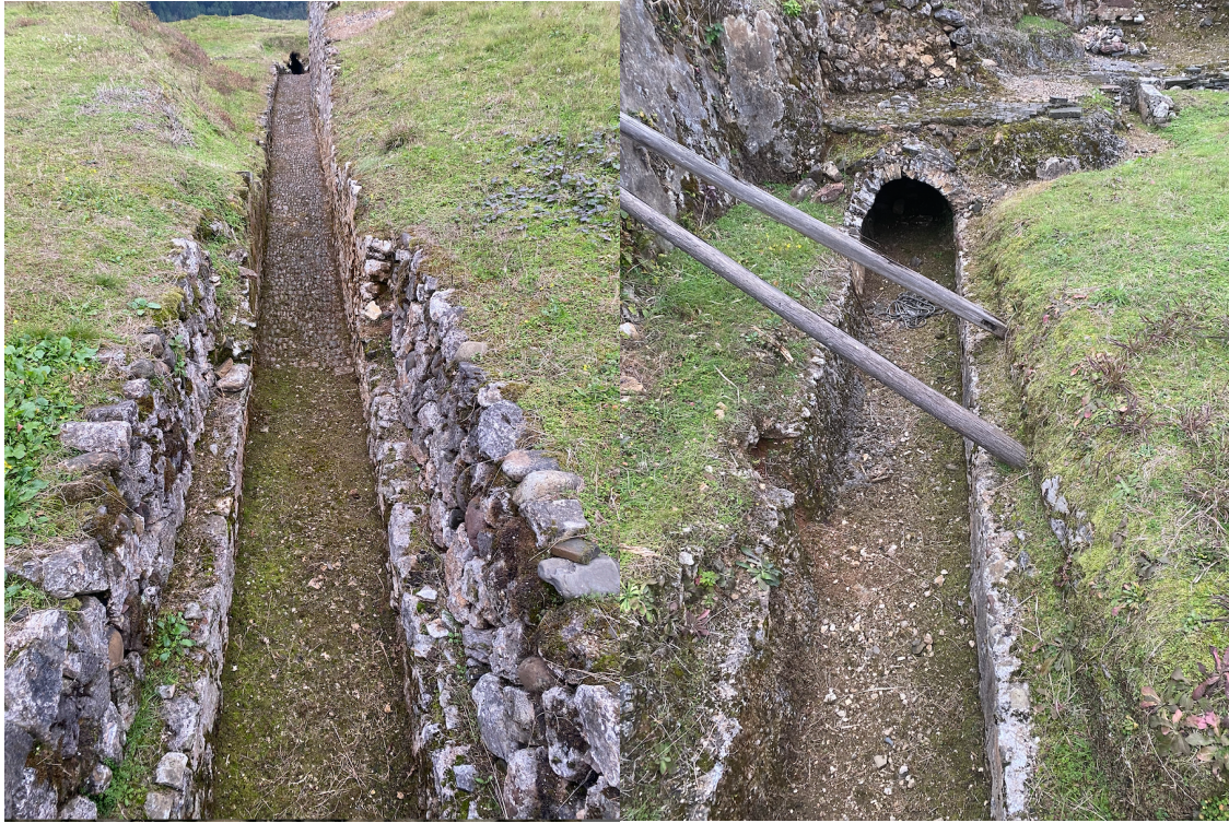
Restos del alcantarillado de Laosicheng
