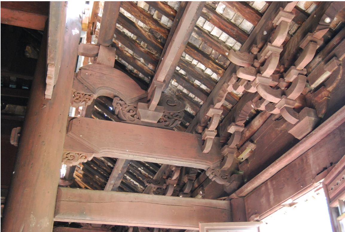
Foto 4.14. Estructura Chuandou de Templo taoísta de Zushi
