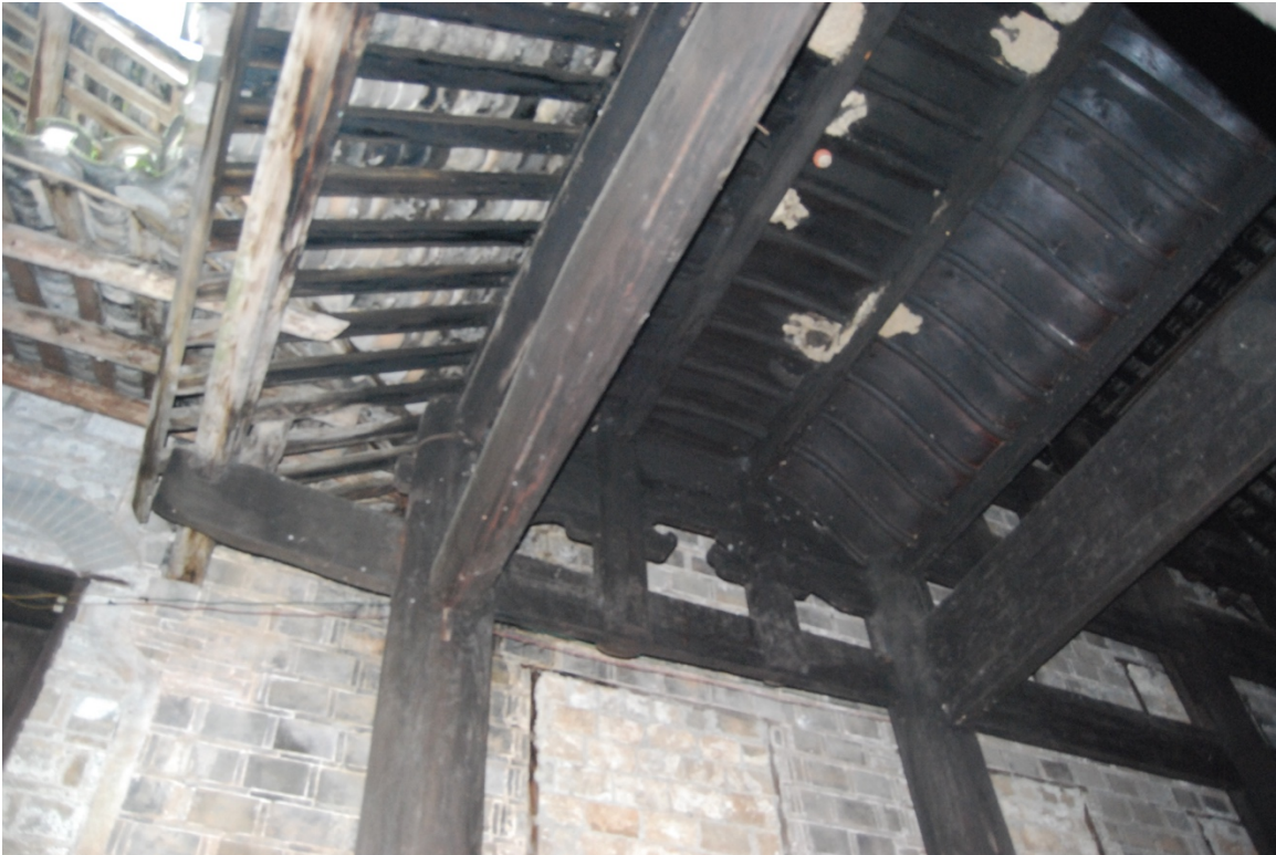
Foto 4.13. Estructura Chuandou de la Sala Ancestral de Tusi
