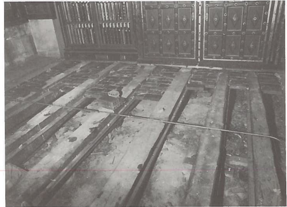
Doble forjado con tablero de rasilla
