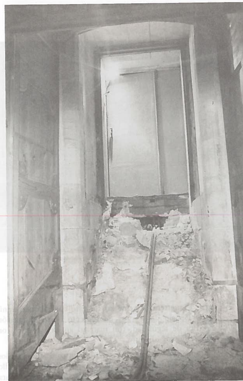
Fue desmontada la pequeña escalera de madera, de acceso a la Sala de Manuscritos e Incunables y sustituida por escalones de granito. Año 1978.
