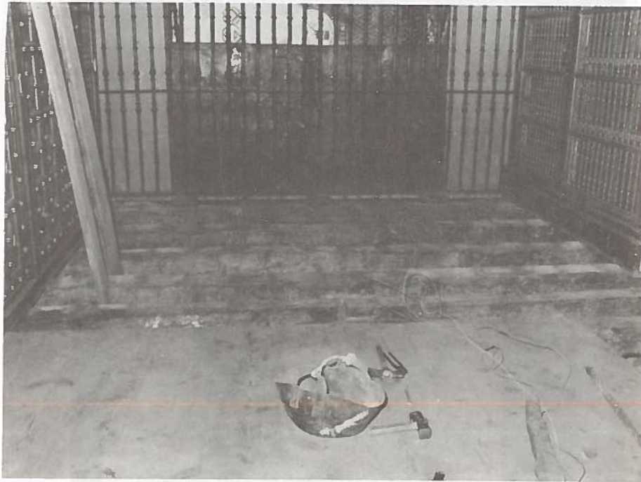
Levantamiento del piso de madera de la Sala de Manuscritos
