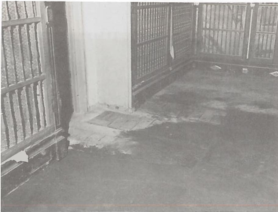
Fue recubierto con capa de mortero de cemento
