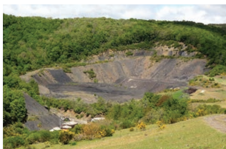
Figura IV.1. Hueco minero en ladera en fase de relleno con estériles de minas cercanas, en “El Sestil” (Guardo, Palencia) (foto: C Martínez Ruiz).
