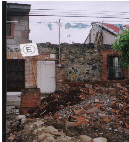
Fig. 5 Degradación del conjunto de viviendas. Fuente: idem .
