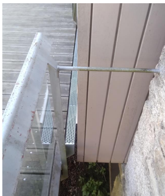
ENCUENTRO ENTRE MURO Y PLATAFORMA
