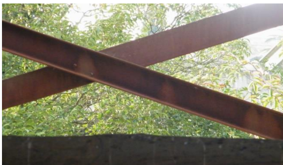
PERFILES DE ARRIOSTRAMIENTO DE MUROS
