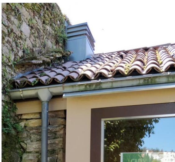
ENCUENTRO DE CUBIERTA Y MURO TESTERO
