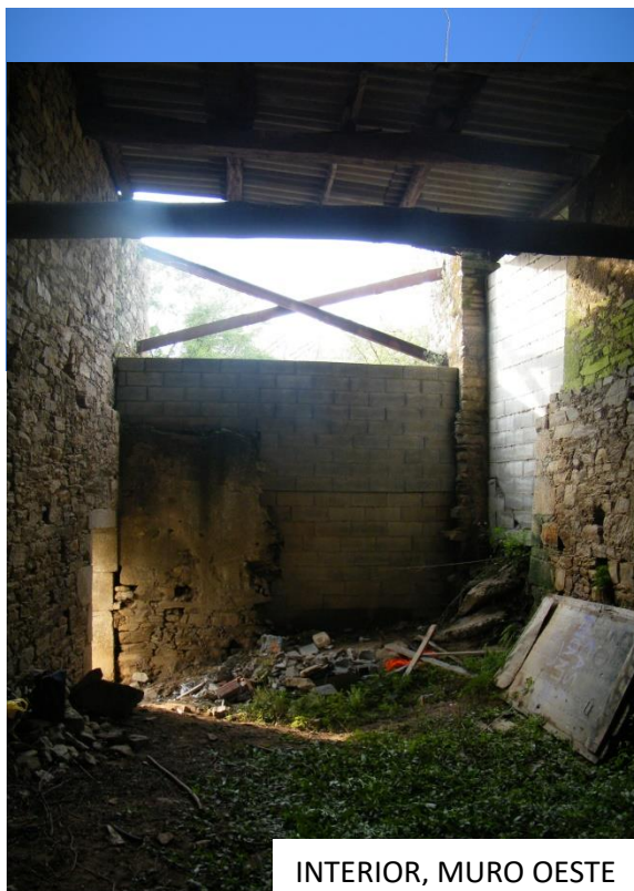
PERFILES DE ARRIOSTRAMIENTO DE MUROS
