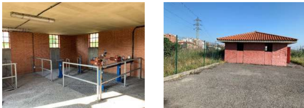
Situación actual del aliviadero.
