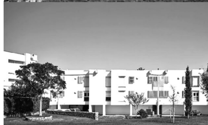
Poblado de Hifrensa (Hospitalet de l'Infant, Tarragona). Viviendas de ingenieros, peritos y obreros.
