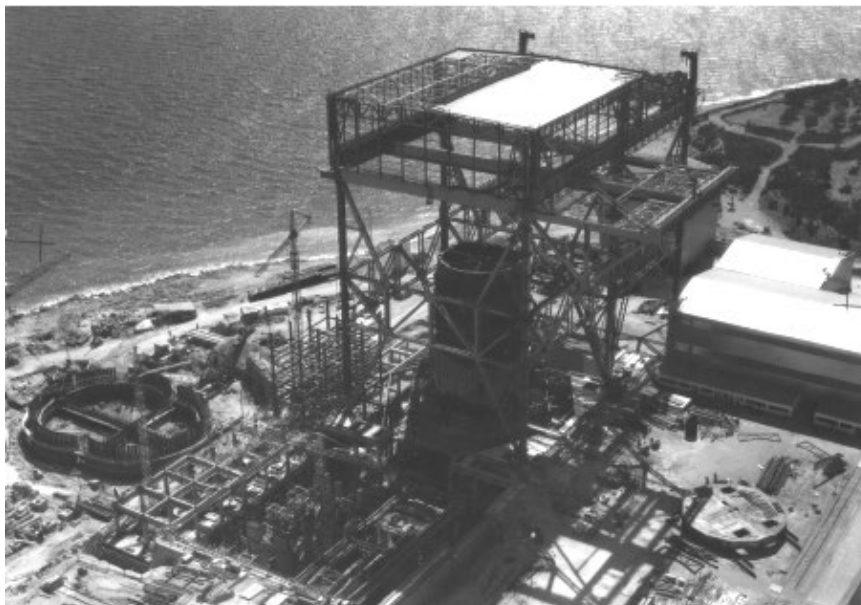
Vista de las obras de la central nuclear de Vandellòs I (cajón del reactor y estación de bombeo), marzo de 1969.
