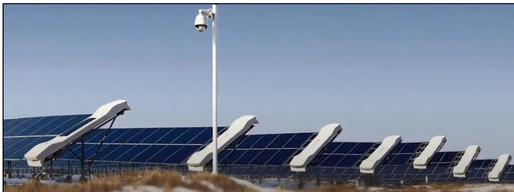
Fig 4.2 (a): Limpieza de paneles solares mediante robot deslizadores automáticos . [29]
