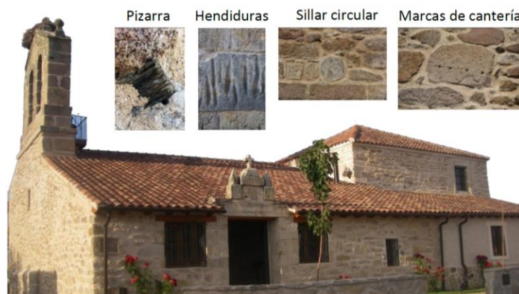
Figura 23. Iglesia de San Miguel situada en la parada 6, con detalles de las rocas que se pueden observar en su fachada (Museo de la Falla, 2022).
