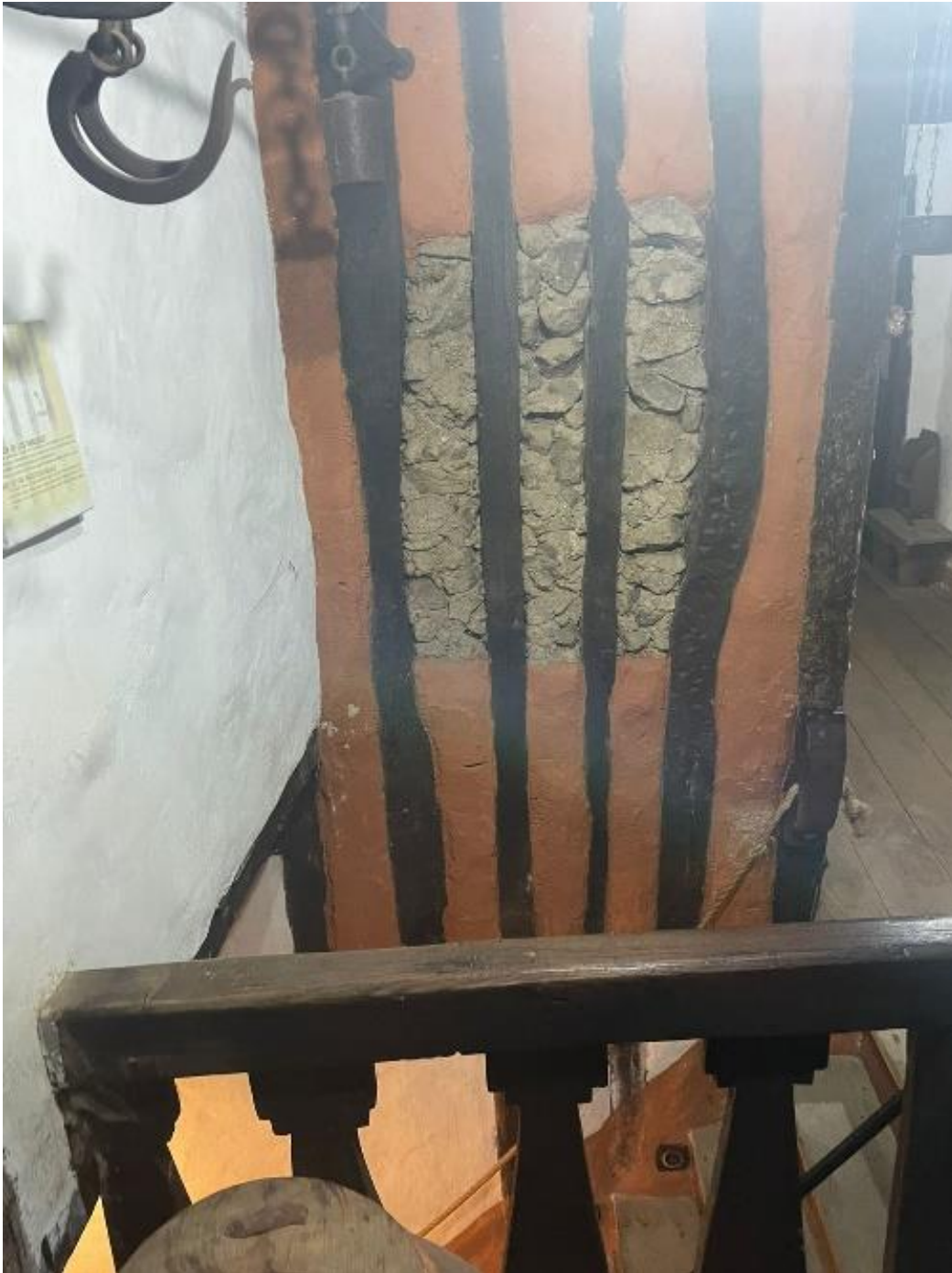
Figura 24: Este pequeño trozo de tabique se ha dejado sin revocar para que observemos cómo son estos muros interiores, que también sostienen parte de la estructura. Fuente elaboración propia
