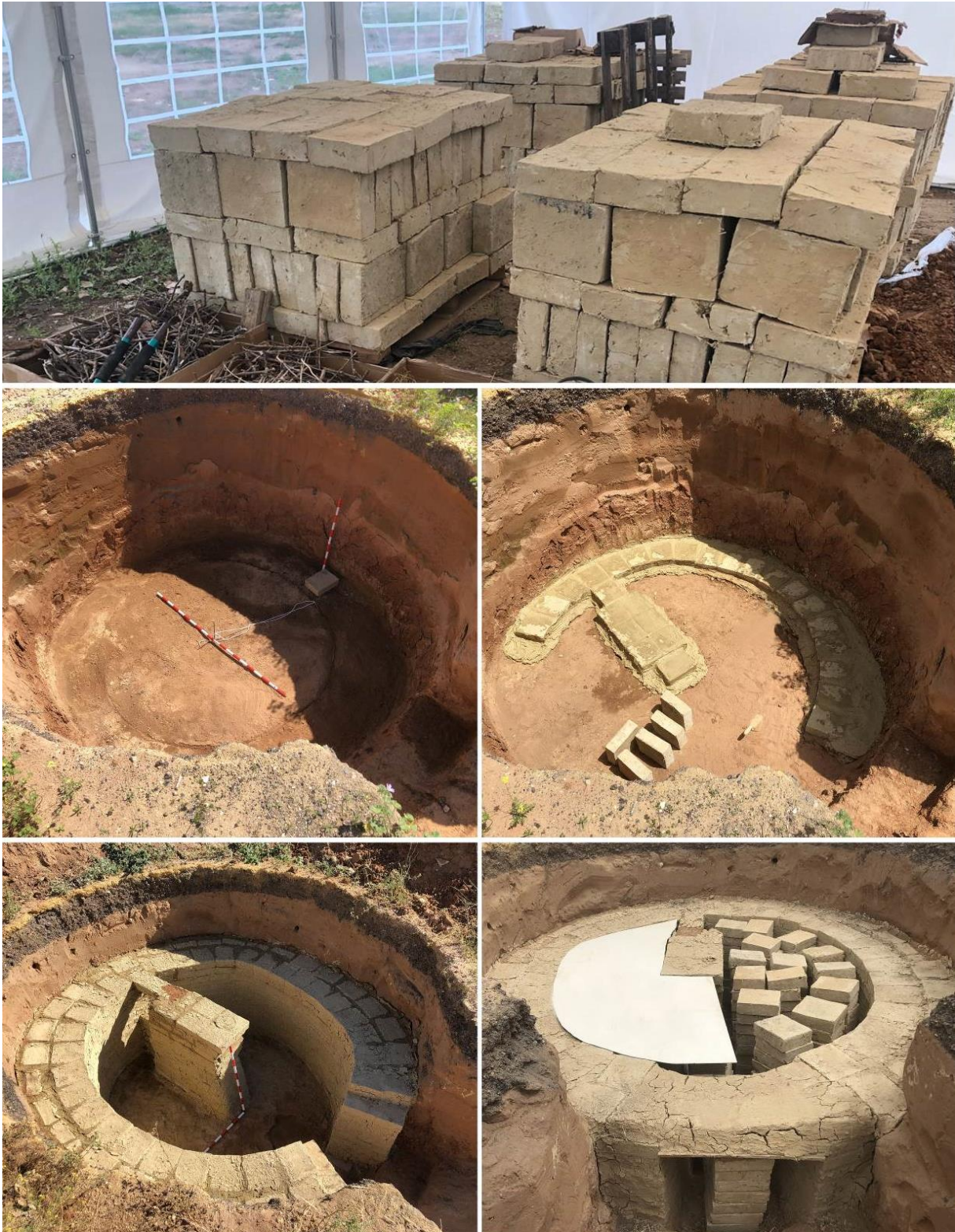
Figura 7. Proceso de construcción de la cámara de combustión del horno experimental empleando como referencias los modelos H3 y H4 del alfar de Camposoto (San Fernando, Cádiz).
