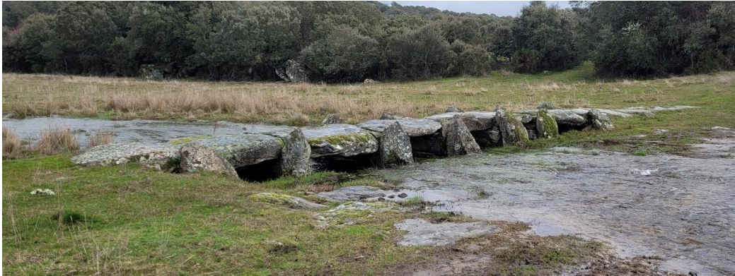
Puente de piedra
